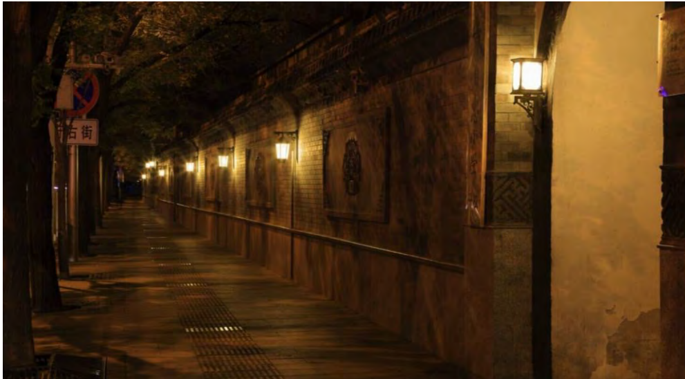
连续墙面（砖墙）
