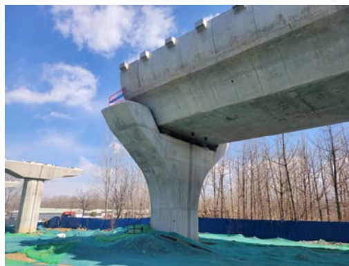
图 4.4 现状轨道线路墩柱
