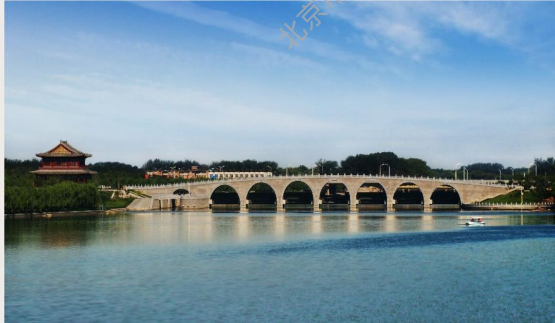
温榆河尹各庄分洪枢纽位于北关闸上游7公里处，水闸方案设计统筹考虑温榆河生态静谧之美、休闲旅游功能、历史漕运文化、现代文化创意等元素，突出简约、时尚、现代、内敛的特点，作为“通州堰”重要的控制性建筑物，拦河闸共9孔，单孔净宽为12m，分洪闸共5孔，单孔净宽10m，均采用钢筋混凝土开敞式水闸结构。
